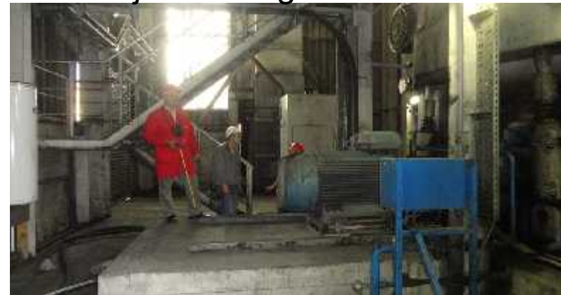
Završna montaža i balansiranje
