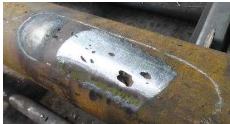
Priprema oštećene površine-brušenje
